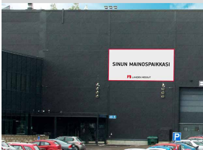
2. Lahti Hallin seinän jättilakana
